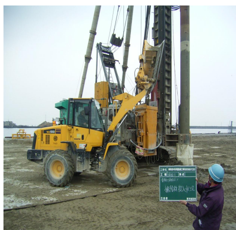
《残土使用補給材 投入》
