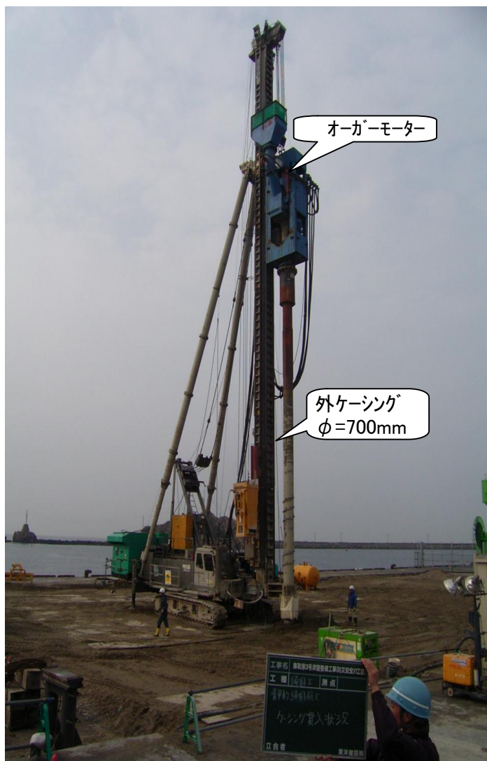
《施工状況 全景》
